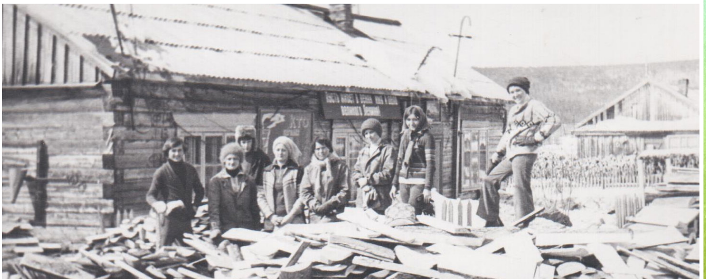
Строительство нового детского сада, субботник
